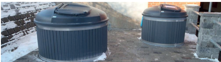
Det er syv affaldsanlæg som disse i Pærevangen, vi etablerer i grf Kirsebærvangen.
